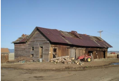
Above: Como Depot prior to restoration
